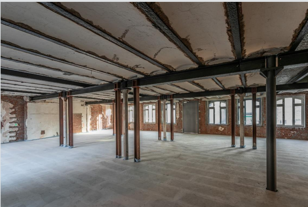
Ansicht 1. OG – die historische Rippengewölbedecke ist hier erhalten.
