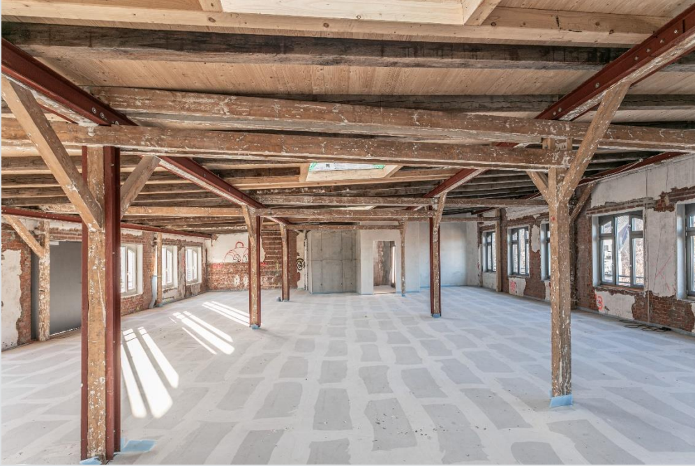
Ansicht 3. OG – die historische Holzdecke beinhaltet zusätzliche Dachluken für mehr Tageslicht.
