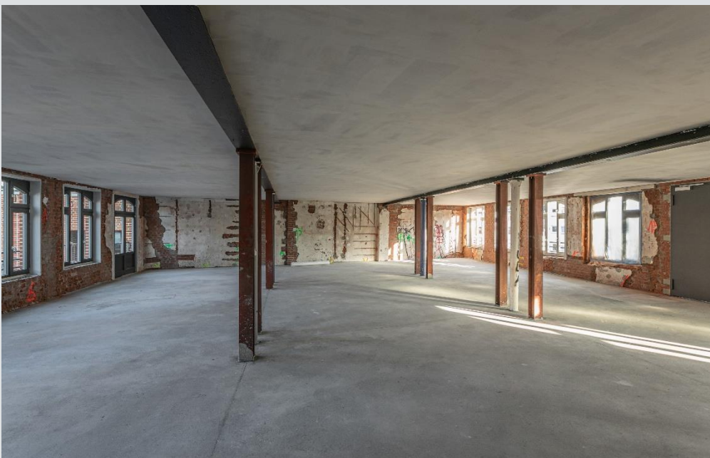
Ansicht 2. OG – hier sind Boden und Decke glatt verputzt.
