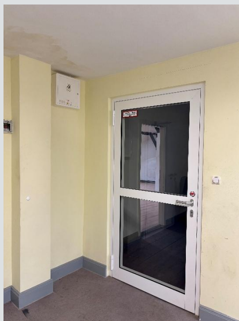
Eingangstür (Blick aus Flur)
