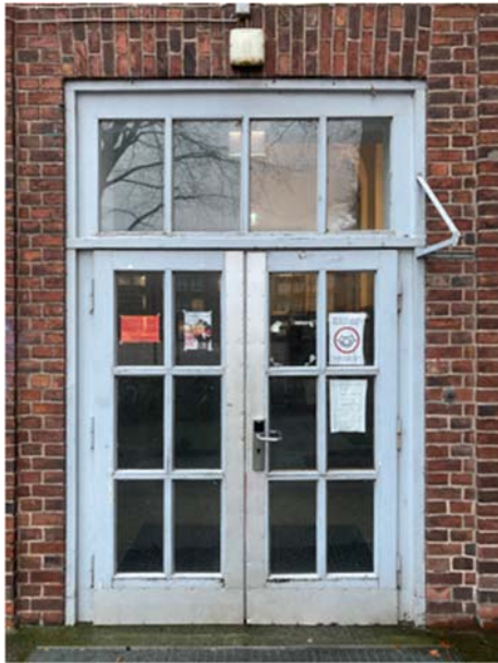
Einbausituation: Dichtschließende Innentüren mit Schallschutzanforderungen, raumseitig
