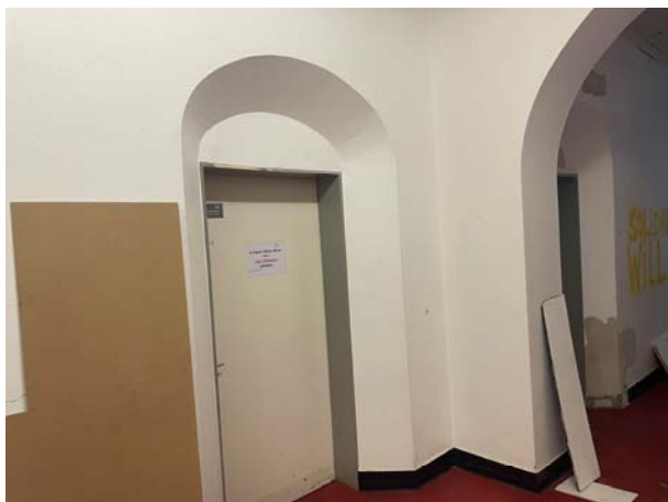
Einbausituation: Zargenvariante 1 Innentüren, flurseitig
