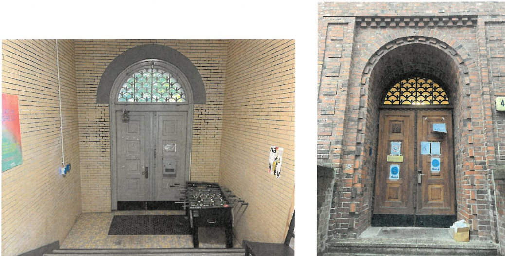
Pos. 04.1 + 04.2 Überholungsbeschichtung, Außentüre profiliert mit Rahmen, innen + außen
