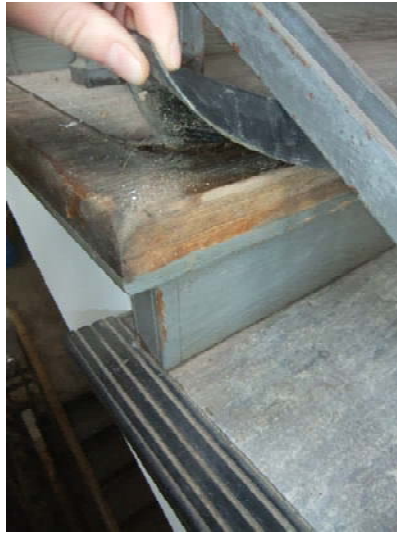
2.4 Linoleum auf Treppenstufen, Breite ca. 0,90 m
