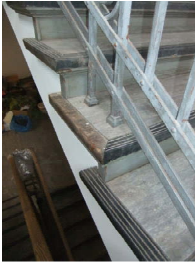
2.4 Linoleum auf Treppenstufen, Breite ca. 0,90 m
