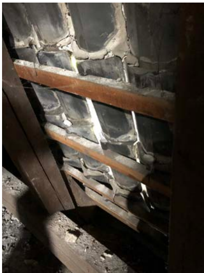
Pos. 13.2 + 13.14 Wartung und Reparatur Hauptdach, Mörtelverstrich
