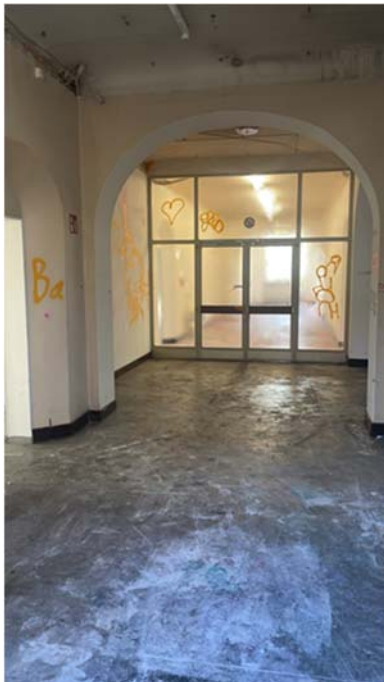
Im Hintergrund Einbausituation Pos. 3.3 Stahl-Rohrrahmen-Feuerschutztür, T30/RS-2, OL und Ausschnitt
