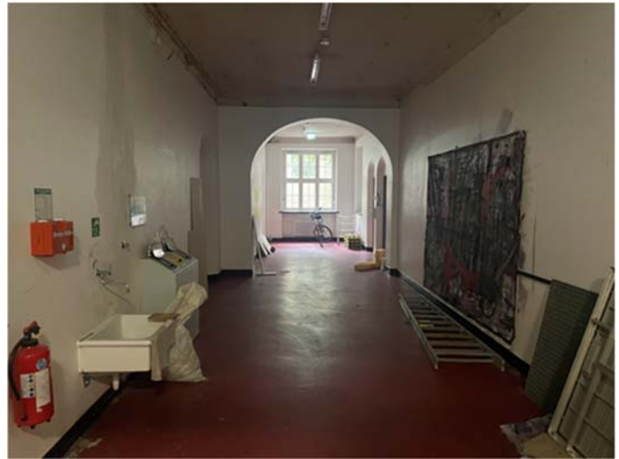
Im Hintergrund Einbausituation Pos. 3.3 Stahl-Rohrrahmen-Feuerschutztür, T30/RS-2, OL und Ausschnitt
