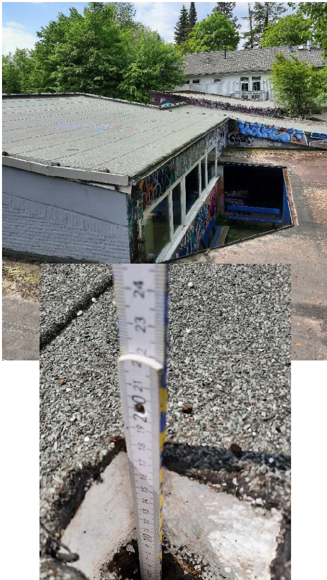
Bilder 4 und 5: Ansicht Dach Hauptgebäude und Bereich zwischen der Disco und dem Hauptgebäude, asbesthaltige Dachpappe in dem Zwischenbereich und Detailansicht der Dachöffnung Hauptgebäude, Probenummern 210489-021 bis -025.
