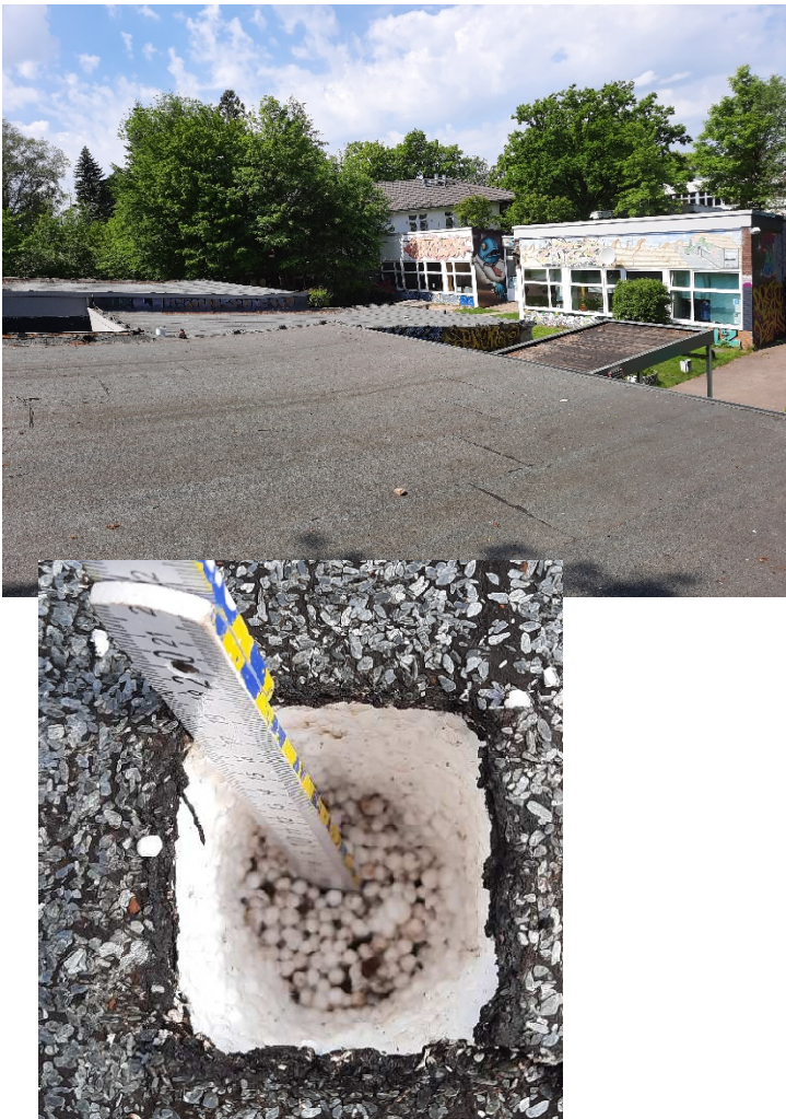
Bilder 8 und 9: Ansicht Dach südliches Gebäude und Detailansicht der Dachöffnung des südlichen Gebäudes, Probenummern 210489-026 bis -029.
