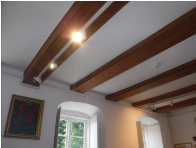
Bild 3: Cafe: die Balken sind vollflächig verkleidet. Die drei „Balken“ rechts ließen kein Holz im Auflager erkennen. Offenbar versperrten Stahlträger den Weg.
