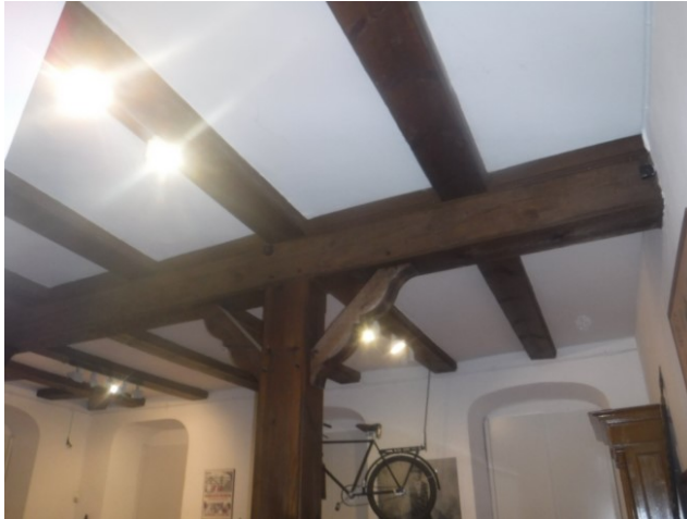
Bilder 1 und 2 („Stube“, Milchwirtschaft): Übersicht über die Decke über dem Erdgeschoß. Die Balken liegen unterseitig frei, sind aber jeweils mit einem Brett verkleidet.
