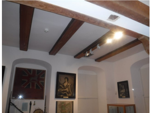
Bilder 1 und 2 („Stube“, Milchwirtschaft): Übersicht über die Decke über dem Erdgeschoß. Die Balken liegen unterseitig frei, sind aber jeweils mit einem Brett verkleidet.
