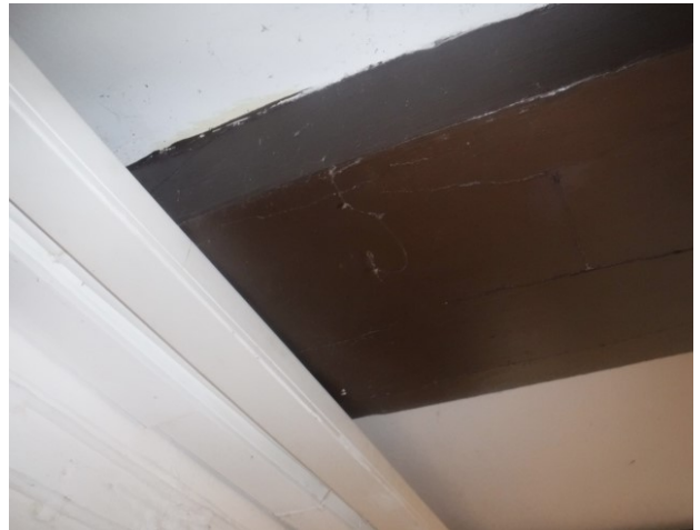
Bild 4: Die Balken im Eingangsbereich sind mit Gips ummantelt. Nur wenige feine Risse zeigen, daß seit Jahrzehnten keine Verformungen eingetreten sind.
