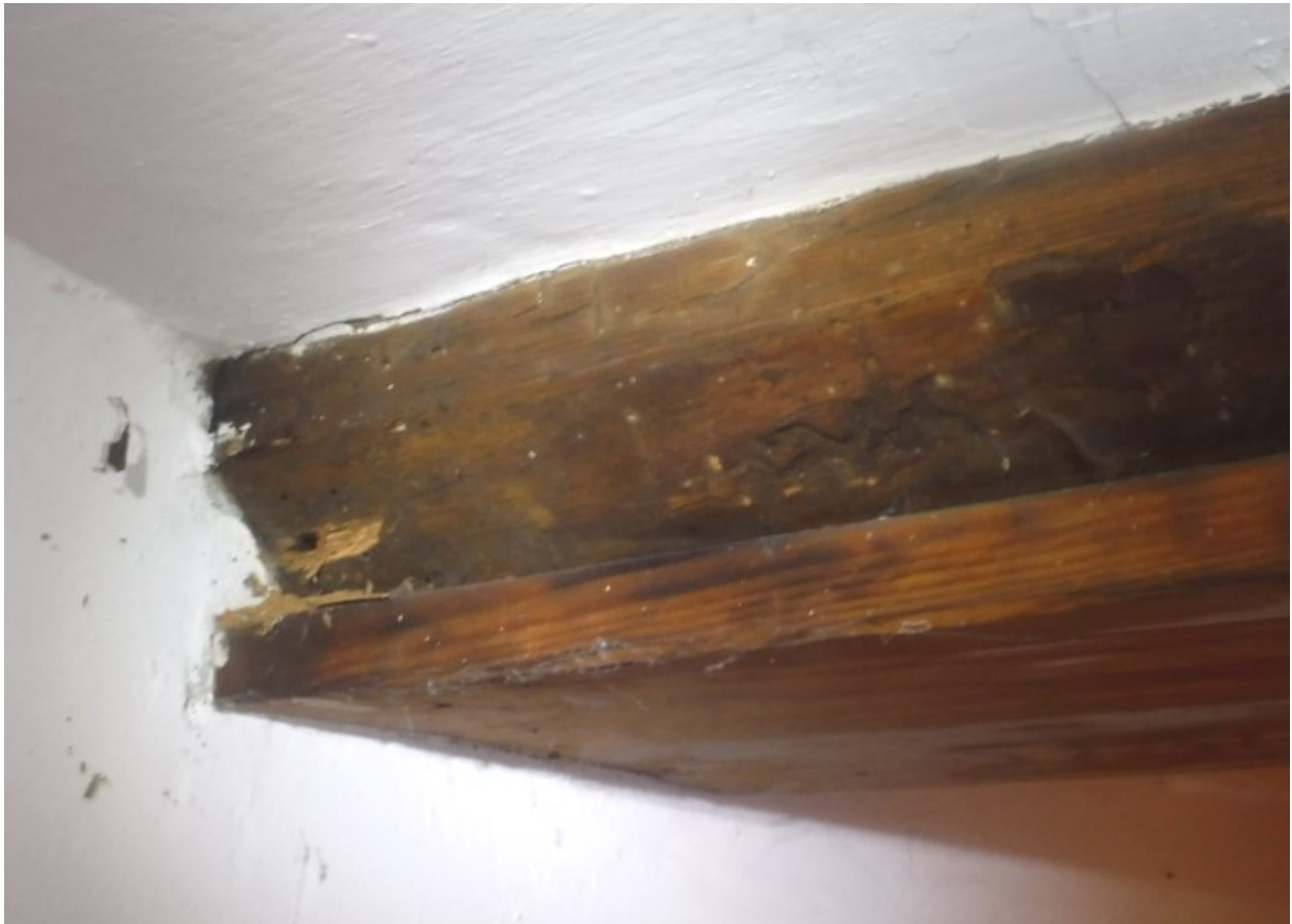
Bild 8: Balken ②, „Stube“: Auch dieser Balken zeigt unten die Waldkante. Einzelne Insektenfraß-Gänge sind sichtbar. Oberflächlich sind Fraßspuren des Scheibenbocks vorhanden. Das Bohrmehl ist pulvrig und dunkel, ein Hinweis auf Schäden durch Pilzbefall. Der Bohrwiderstand war in den äußeren 3-4cm gering. Die dazugehörige Bohrwiderstandsmessung ist in der folgenden Grafik dargestellt:
