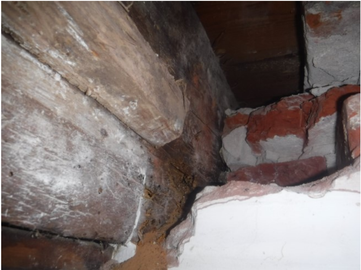
Bild 7: Öffnung ①: der Balken zeigt unten rechts die Waldkante (die abgerundete Oberfläche auf der sich am lebenden Baum die Rinde befand. Dieser Bereich besteht somit aus nicht dauerhaftem Splintholz). Einzelne Insektenfraß-Gänge sind sichtbar. Das Bohrmehl ist pulvrig und dunkel, ein Hinweis auf Schäden durch Pilzbefall. Der Bohrwiderstand war in den äußeren 3-4cm gering.
