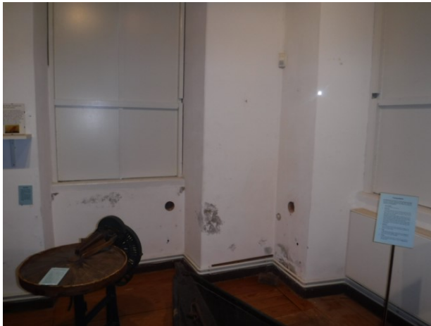
Bild 1: Abblätternde Farbe deutet bereits auf Feuchteprobleme an der Außenwanddecke hin.
