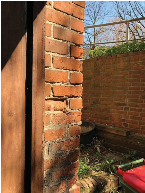
Detail Klinkerschäden
